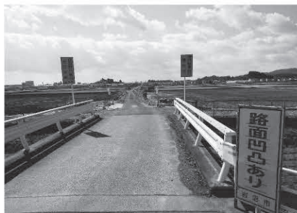
朝日2号線の橋
