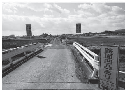
朝日2号線の橋
