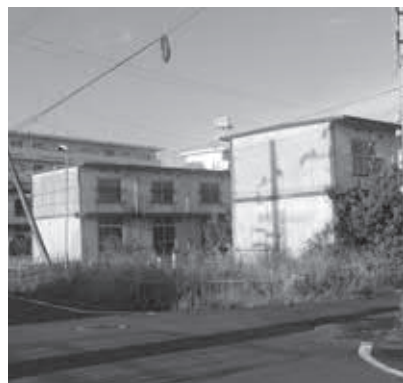
年度内に解体される予定の市営亀塚第一住宅
