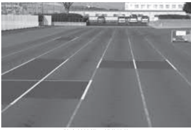
陸上競技場の部分改修
