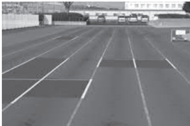
陸上競技場の部分改修
