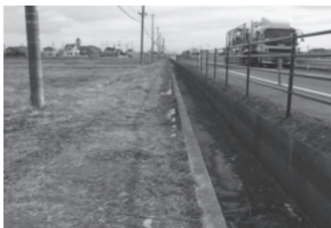
県道岩沼海浜緑地線北側の水路脇
