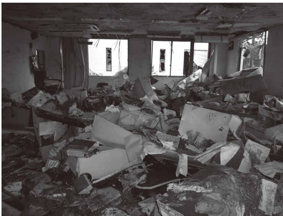
浄化センター管理棟1階事務室の被災状況
