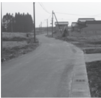
防犯灯が設置されていない例
