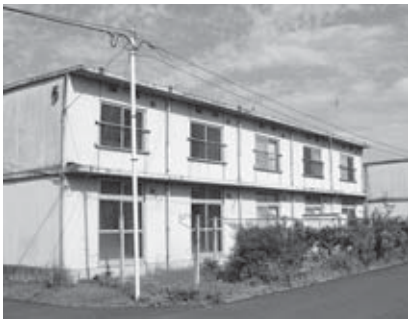
亀塚第一住宅
