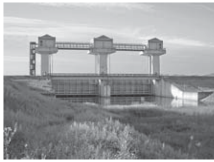
押分排水機場
