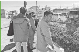
大戸堀水路 改修工事確認
