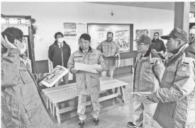
ハナトピア岩沼 施設改修工事確認
