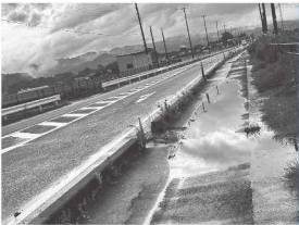
長岡1号幹線工事 視察
