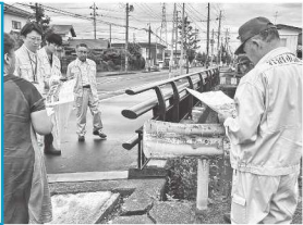
江戸橋補修工事 視察
