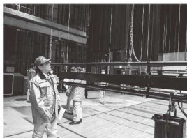
岩沼市民会館 舞台上部吊物 ワイヤー部分 確認
